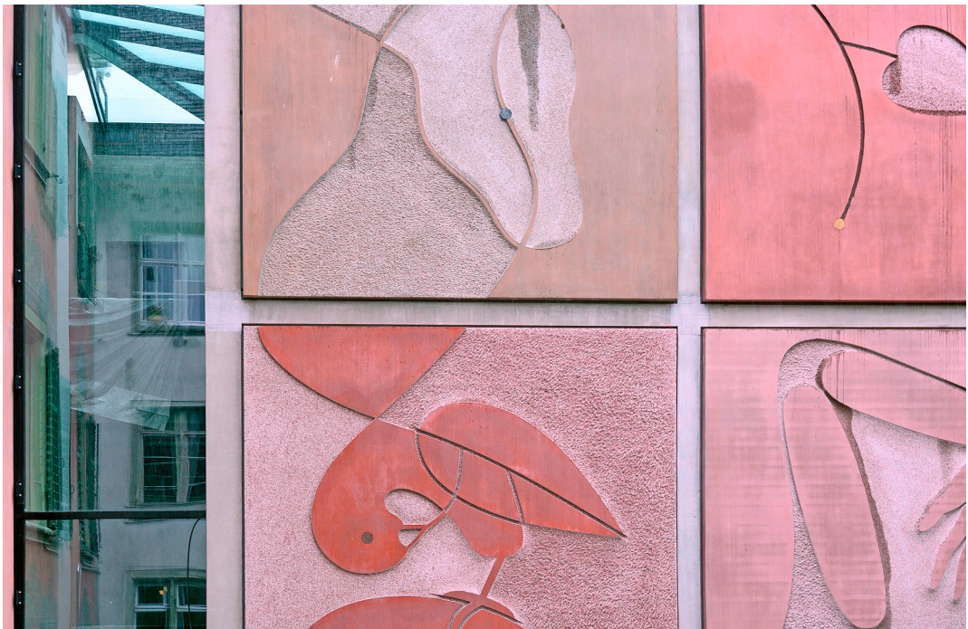
Die Fassade des neuen Stadthauses zieren elf Betonplatten mit Motiven des Künstlers Yves Netzhammer. Sie wurden mit einem Spezialroboter vorgefräst und danach von Hand ausgearbeitet.
